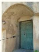
Pierre percée en débord (libbia) servant à fixer la longe
