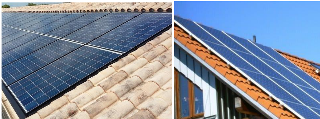
Exemple de panneaux solaires intégrés par rapport à la pente de la toiture
