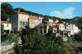
La maison de maître se détache par son volume. Les grandes ouvertures éclairent la loggia
