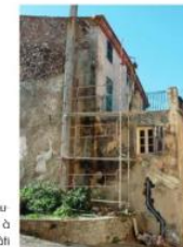
Sortie de ventilation en façade
