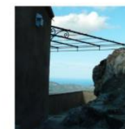
Structure métallique discrète
