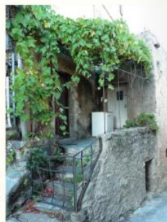
Les décalages entre les volumes créent des micro-espaces protégés du soleil et du vent.
