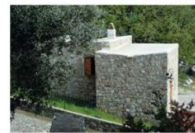
Les petits volumes peuvent être couverts d'un toit-terrasse traditionnel sans auvents (débord supérieur des murs).
