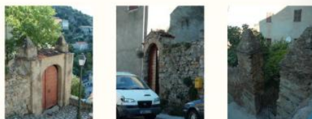
Dans les villages de piémont et de bord de mer, les entrées sur cour peuvent être fortement soulignées de piliers massifs, frontons...
