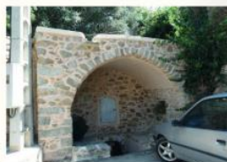
La teinte des joints se différencie trop de celle de la pierre.
