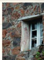
Enduit de tuf à Praggiola recouvert d'un lait de chaux blanc.
