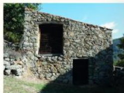
Grande porte de remise à l'étage pour faciliter le stockage et la manutention
