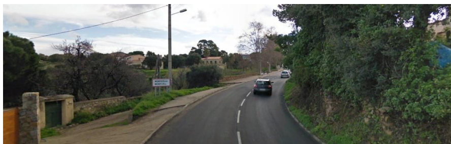
Entrée de ville (2) depuis l'Ouest de la T10
