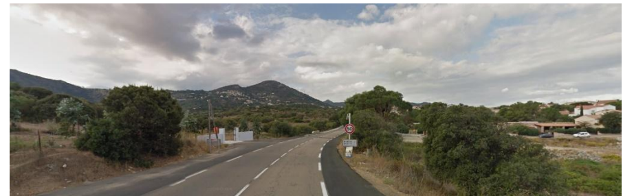
Entrée de ville (1) depuis l'Est de la T10
